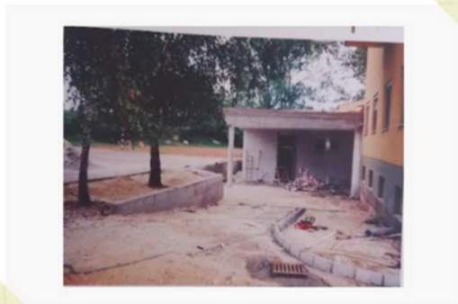
Pričetek gradbenih del prizidka
